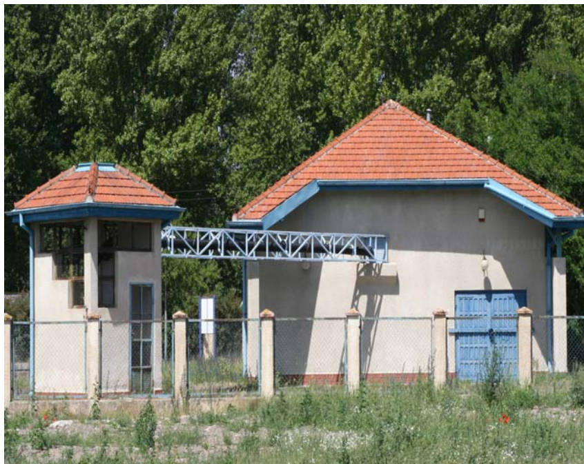
Ujęcie wód solankowych dla sanatorium „Helios”
